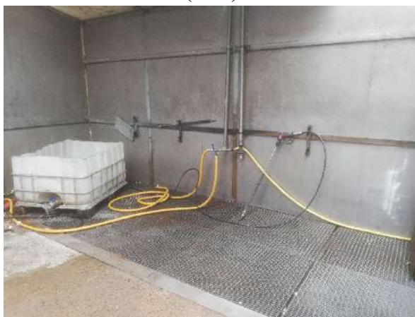
Zone de lavage extérieur atelier plastique (LAV2)
