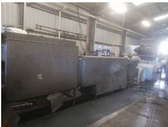
Zone de broyage avec la fosse de 50 m 3 (DEC4)
