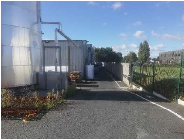
Zone de stockage des broyats et cuve d'eau propre
